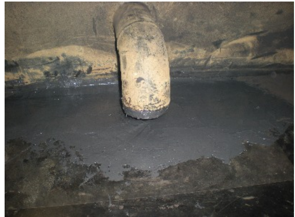
底板ドレン配管近傍
