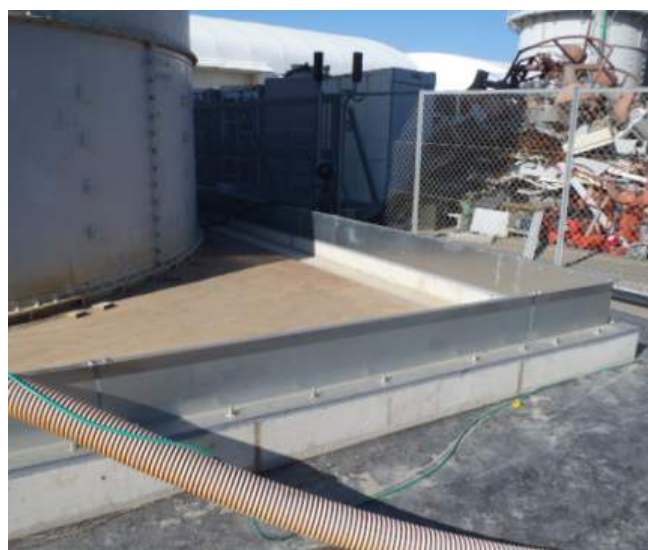
【B南タンクエリア堰の嵩上げ状況】
