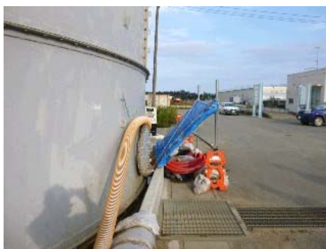
【歩廊から滴下した水を堰内へ導くためのシート設置状況】
