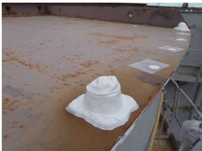
【B南タンクエリア内のタンク天板部コーキング処理状況】
