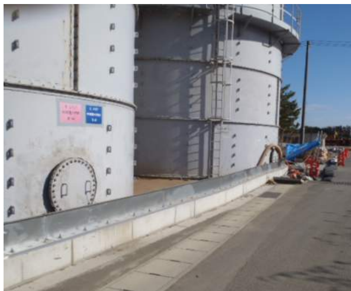
【B南タンクエリア堰の嵩上げ状況】
