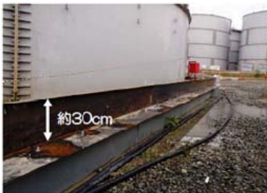
写真3 鋼製板による堰の設置状況 (H4 北エリア)
