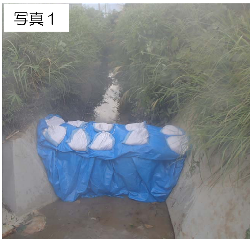
排水路内土のう式堰設置(8/27)
