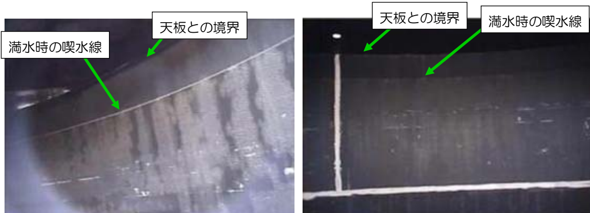
図3 No. 5タンク内面の喫水線
