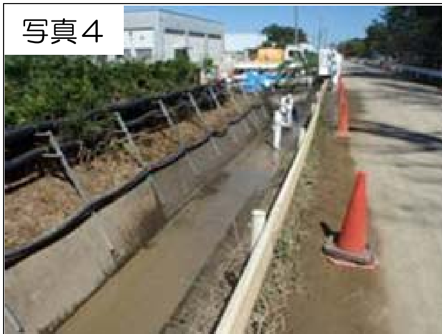
排水路内洗浄(9/9撮影)
