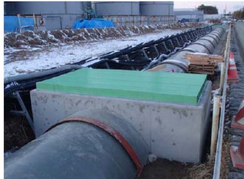
③FRP管施工完了（撮影日H26.2.7）
