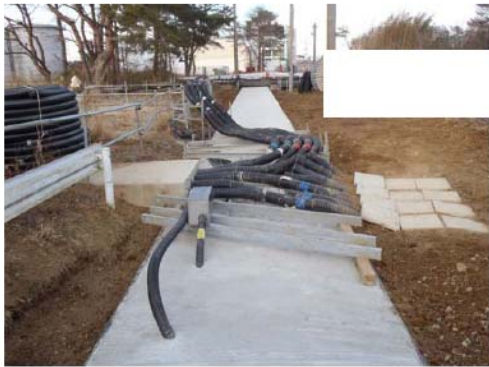
②コンクリート蓋施工完了（撮影日H26.1.22）
