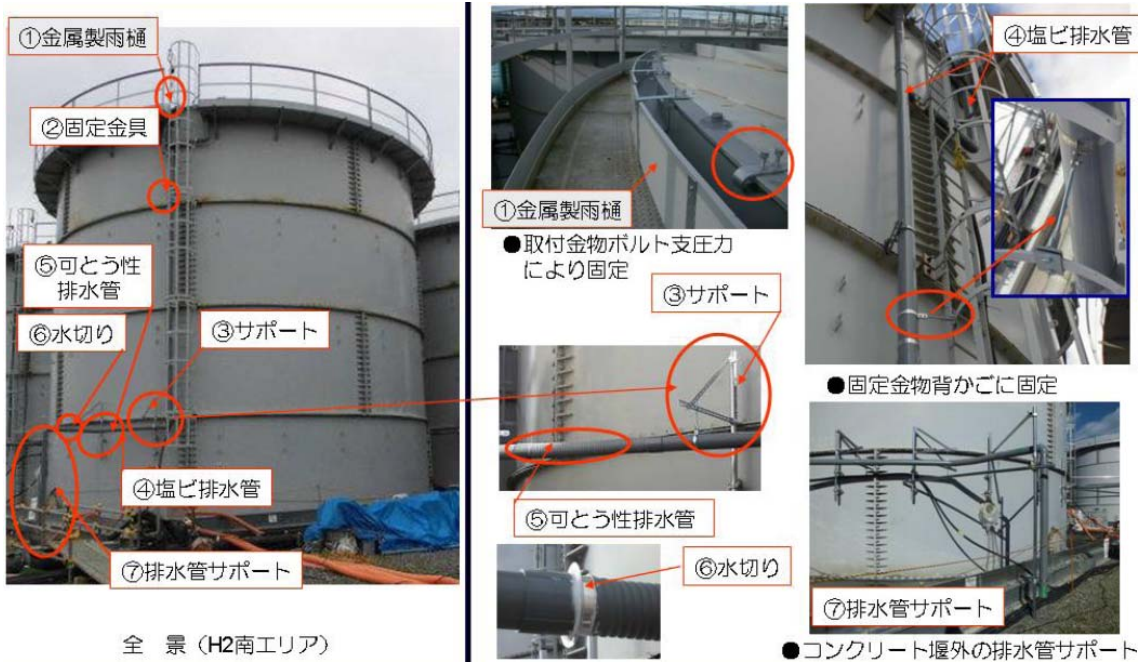
写真7 タンク天板への雨樋設置状況
