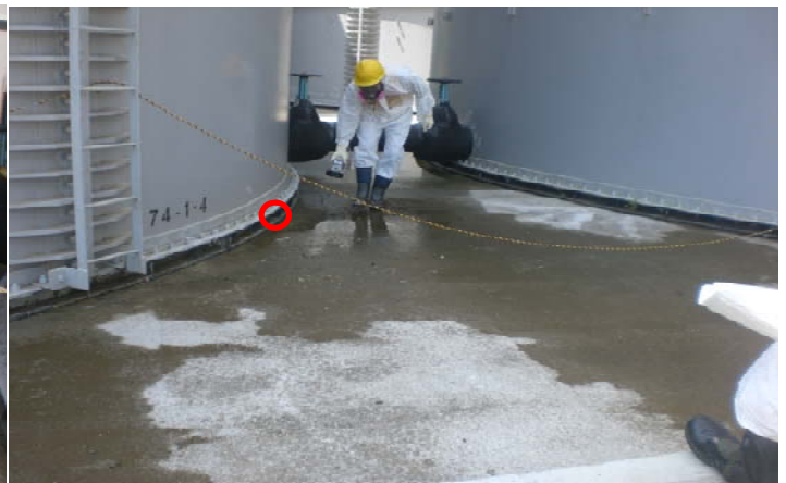
図3 No. 10タンク高線量箇所
