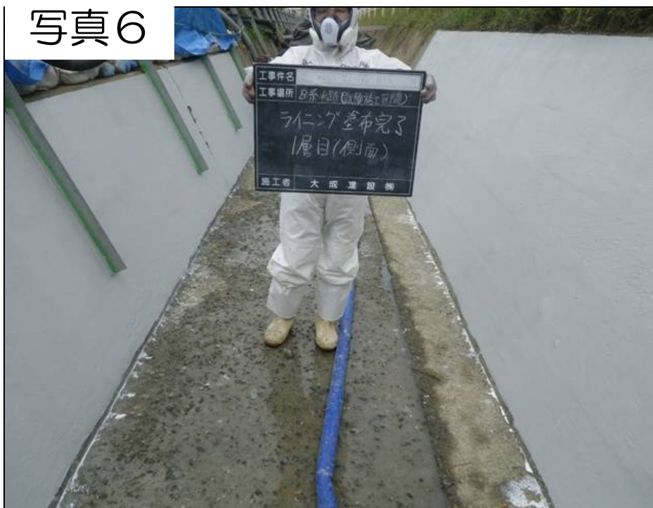
ライニング実施状況(10/10撮影)
