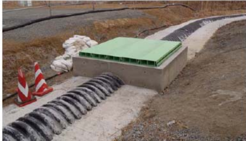
①ダブルプレスト管施工完了（撮影日H26.1.15）
