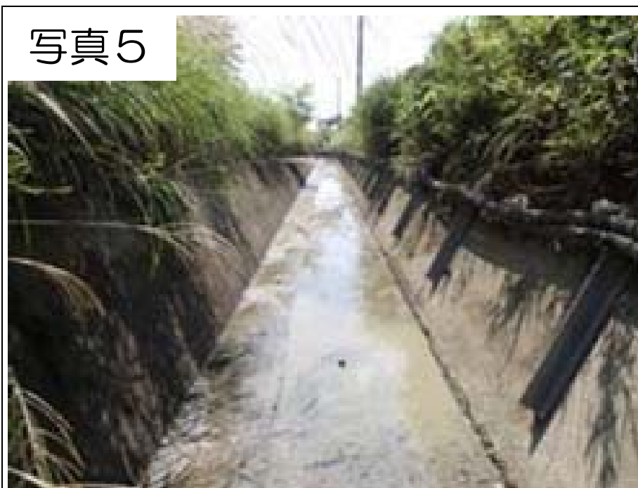
排水路内土のう式堰撤去(9/10撮影)
