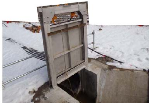
④止水ゲート施工状況（撮影日H26.2.12）
