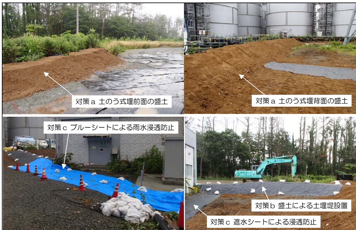
図4 土のう等施工状況
