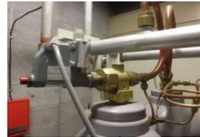
2009年3月の消防通達により、ガス消火設備(容器弁)の定期的な点検が義務付けられ、容器弁点検およびこれに伴うガスボンベ搬送・更新費用が発生した。
