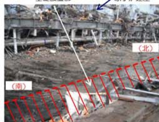
④基礎設置部 (東側、外部)
