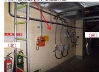
⑤基礎設置部 (東側、内部)
