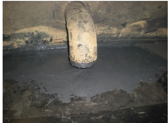
底板ドレン配管近傍
