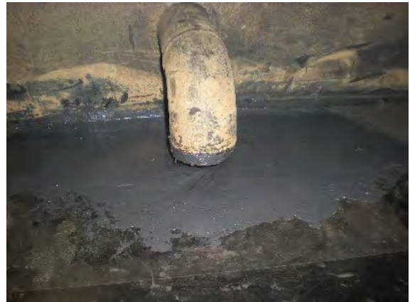
底板ドレン配管近傍
