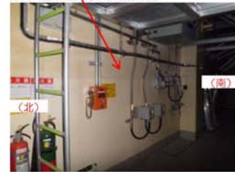
⑤基礎設置部 (東側、内部)
