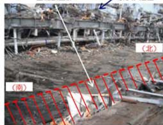
④基礎設置部 (東側、外部)
