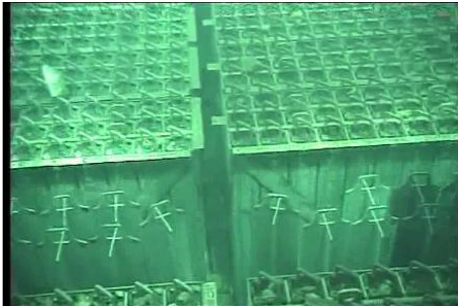
図6-2 4号機SFP内の状況（その2）
