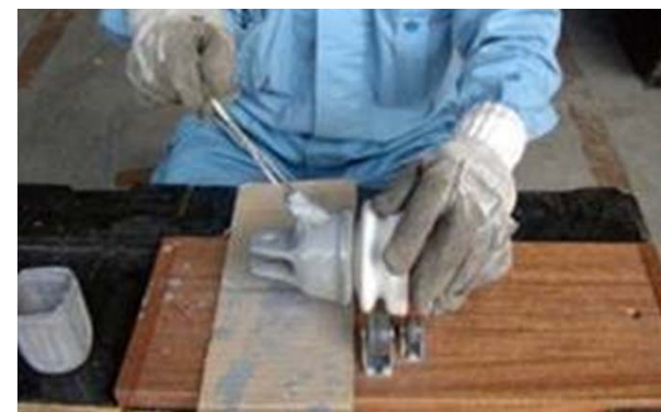
がいし補修作業(金物再塗装)
