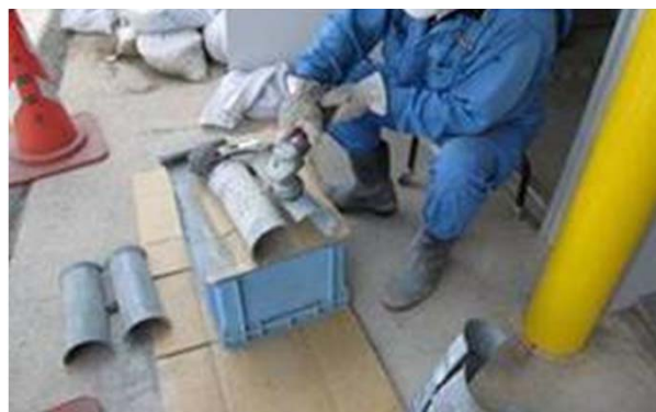
鉄管保修作業(錆落とし)
