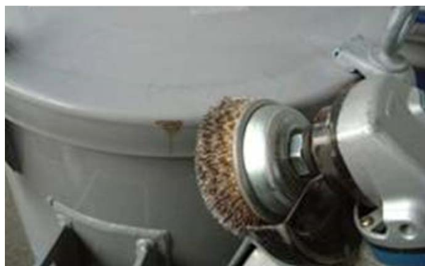
変圧器修理作業(錆落とし)
