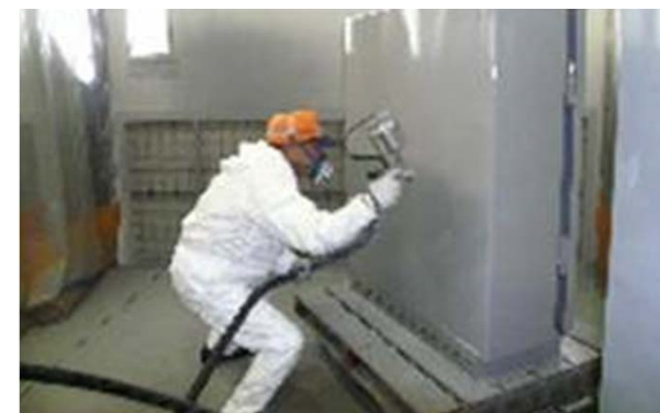
地中機器修理作業(再塗装)
