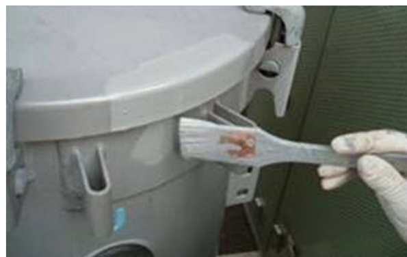
変圧器修理作業(再塗装)
