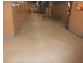
地下1階 (撮影日: 平成24年12月9日)
