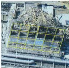
②東面 外壁
