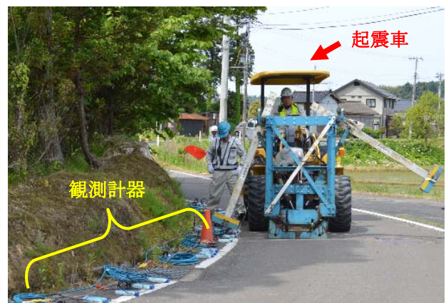
発電所周辺の地下探査の様子（五日市地区）
