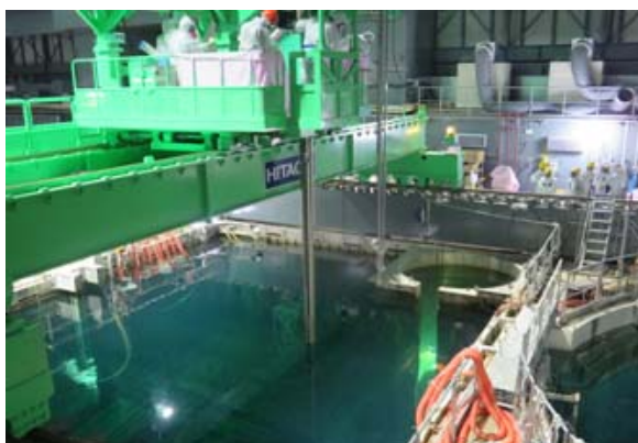
使用済燃料プールからの燃料取り出し作業
