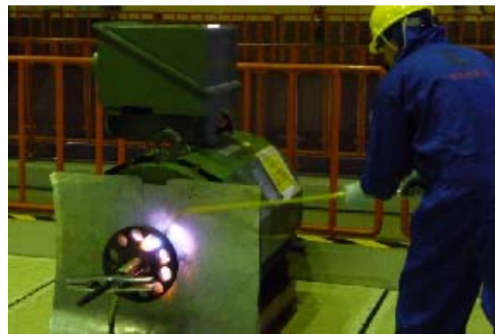
電動機取替訓練 (カップリング取外しのための加熱作業)
