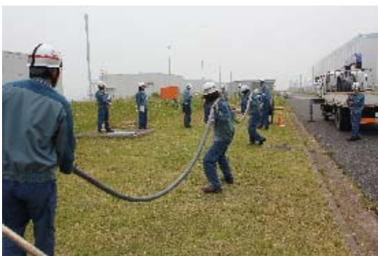
仮設ケーブル接続訓練 (ケーブル布設)
