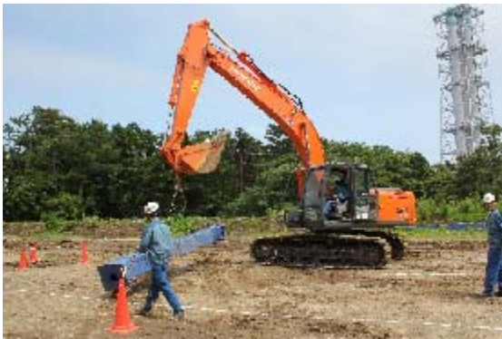
瓦礫撤去・道路復旧訓練 (瓦礫の撤去)
