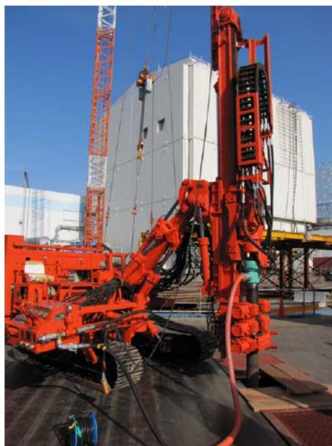
凍結管設置工事実施状況
