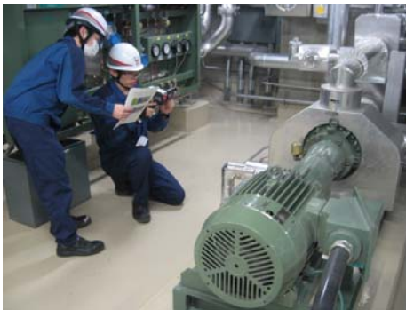
運転員の直営によるデータ採取（例：赤外線サーモグラフィ診断）
