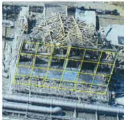
②東面 外壁
