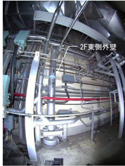
④2F東側外壁
