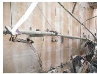
②プール壁異常なし
