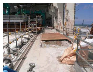
④床異常なし
