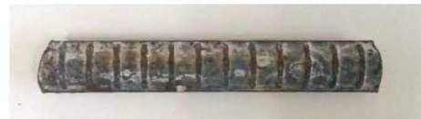
No.2 (腐食グレードI)
