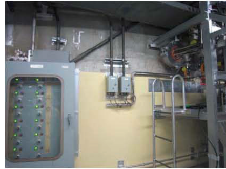
1階 南側シェル壁
