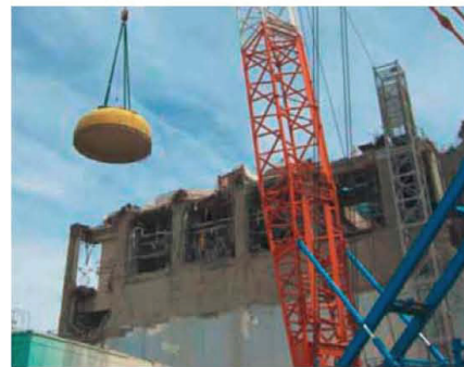
(b) 機器の撤去作業
