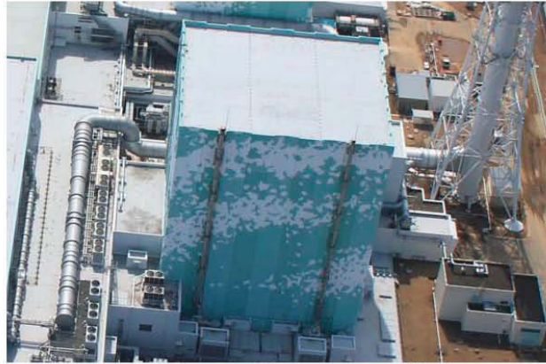
図-1.1 外観写真(北面、3月24日撮影)
