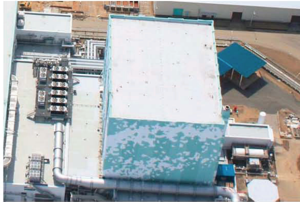
図-1.1 外観写真(北面、3月24日撮影)
