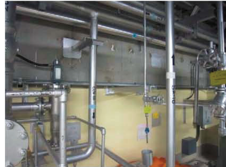
3階 西側燃料プール壁
