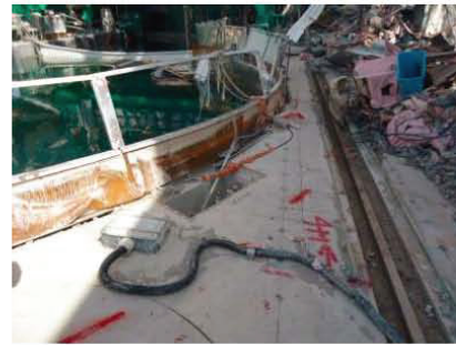
②シェル壁異常なし
