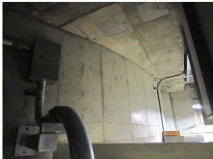
3階 北側シェル壁
