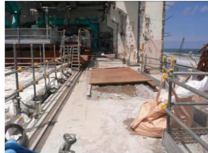
④床異常なし
