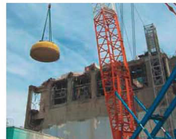
機器の撤去作業 [西面] 撮影日：平成 24年 8月10日
