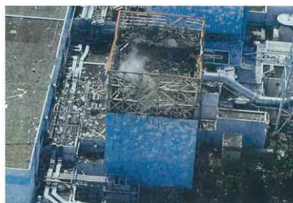
図-3.1 1号機原子炉建屋の損傷状況（立面図）
