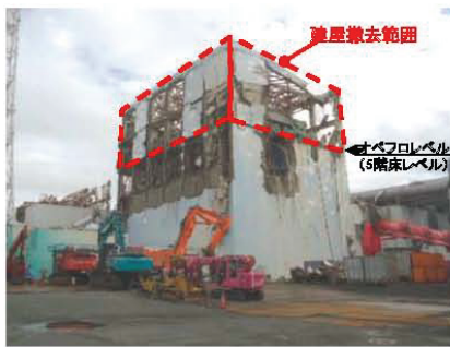
建屋瓦礫 撤去工事 着手前 [南西面] 撮影日：平成 23年 9月22日
