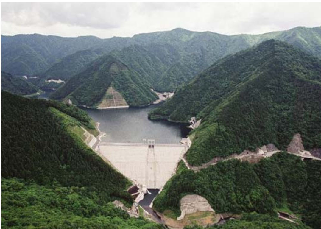
< 下部ダム (葛野川ダム) >
