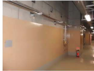
2階 (撮影日: 平成24年12月9日)
