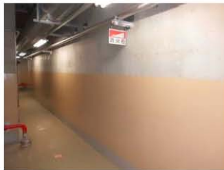
1階 (撮影日: 平成24年12月9日)
