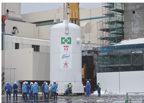
6号機 フィルタベント本体設置工事
