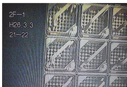
燃料集合体が収まっている状態の使用済燃料貯蔵ラック
