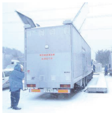
ガスタービン発電機車の 操作訓練
