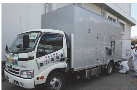
電源車：発電容量(500kVA)は、一般家庭約160軒分の消費電力に相当
