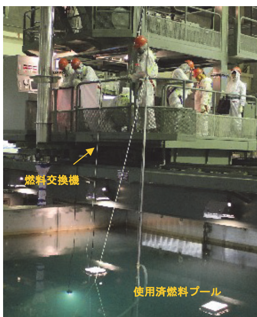
燃料交換機上から水中カメラを吊り下ろしている様子
