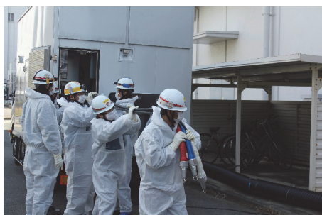
電源車からのケーブル引き出し
