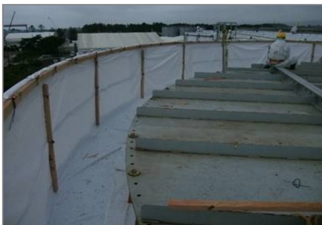
タンク歩廊部
