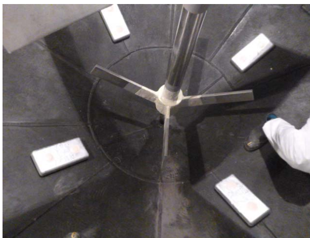
バッチ処理タンク1C （ゴムライニング施工後）
