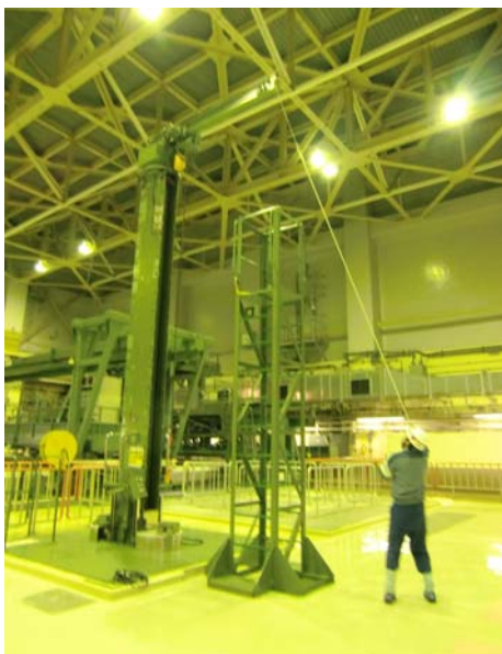
新燃料検査台
