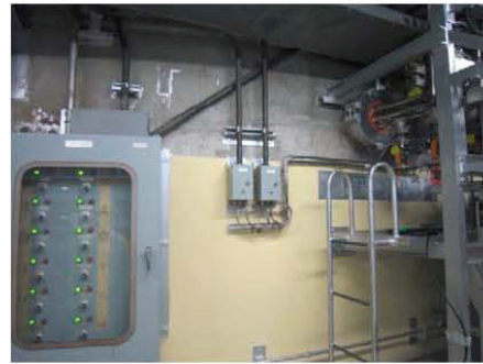
1階 南側シェル壁
