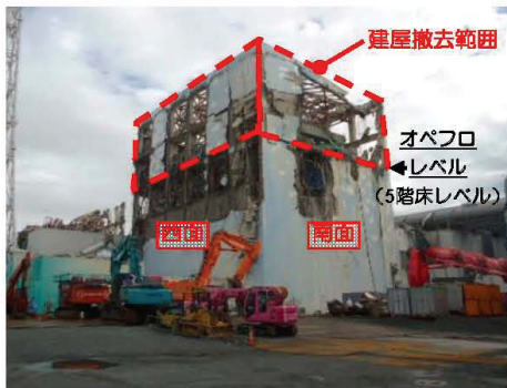
(a) 瓦礫撤去工事 着手前
