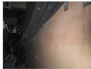
②プール壁異常なし
