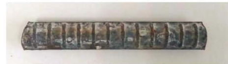
No.2（腐食グレードI）
