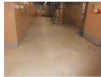
地下1階 (撮影日: 平成24年12月9日)
