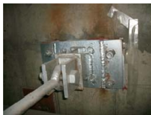
図-3 1号機の配管支持構造物の点検結果
