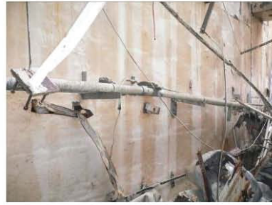
②プール壁異常なし
