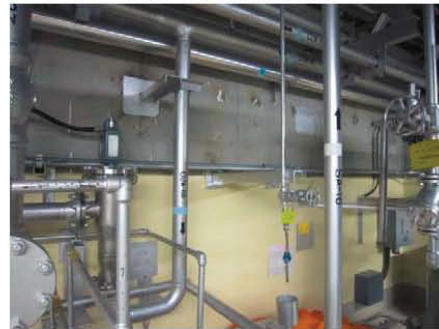
3階 西側燃料プール壁
