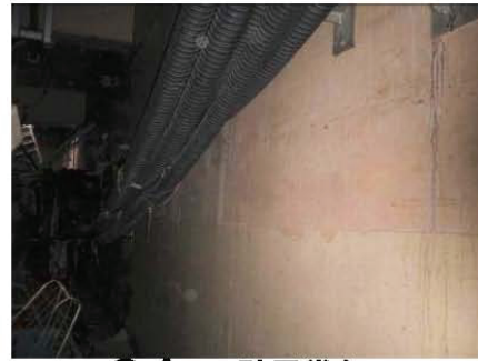
②プール壁異常なし
