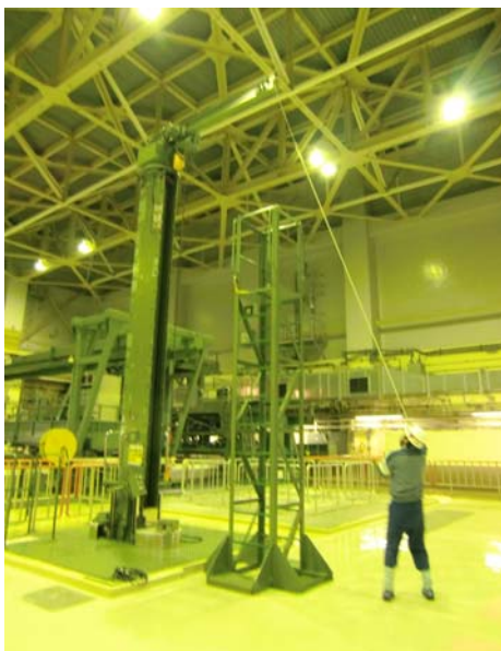
新燃料検査台
