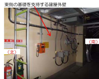
⑤基礎設置部 (東側、内部)
