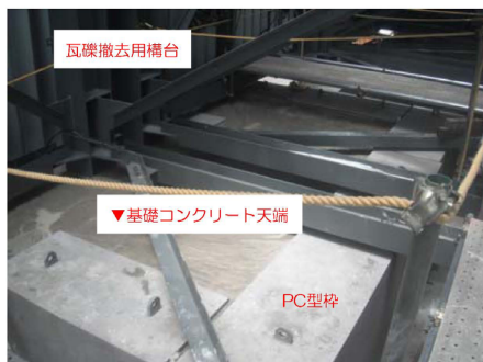
瓦礫撤去用構台西側基礎部 コンクリート打設
