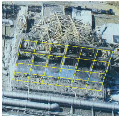
②東面 外壁
