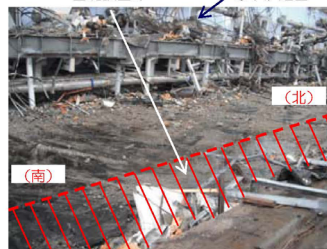
④基礎設置部 (東側、外部)
