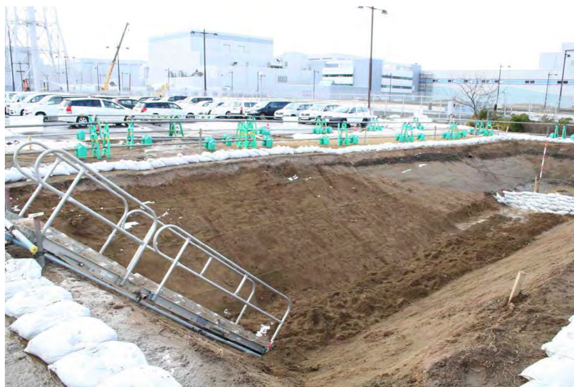
トレンチ南面全景
