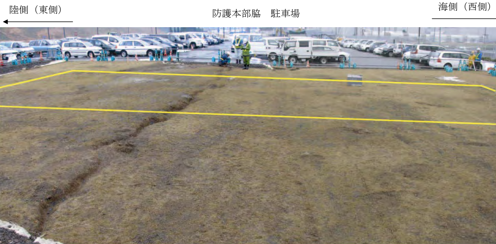
トレンチ掘削範囲
