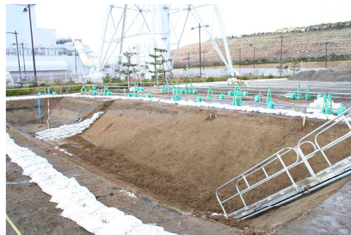
トレンチ北面全景
