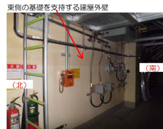
⑤基礎設置部（東側、内部）
