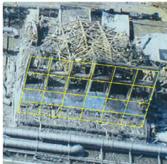
②東面 外壁
