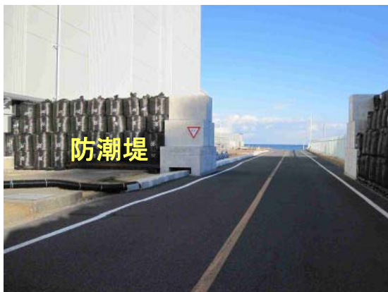
土のうによる 防潮堤の設置 (右図中の黄色箇所)
