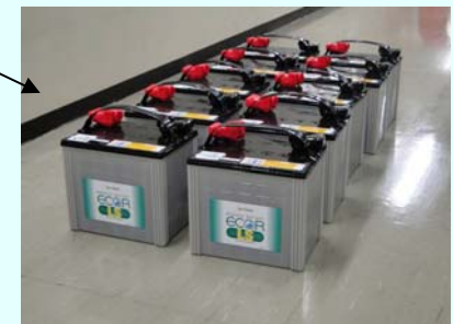
予備蓄電池 (12V×10台/1プラント) 保管場所：下部中央制御室(1号機)
