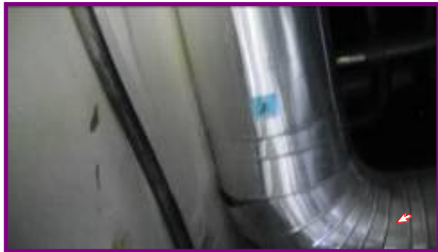
非常用復水器(A)凝縮水戻り配管
