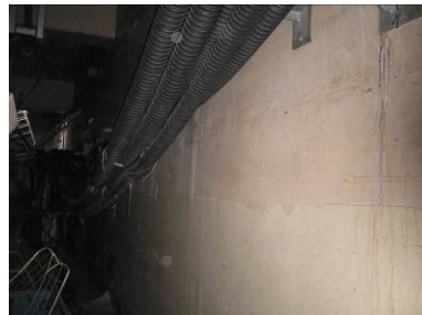
②プール壁異常なし
