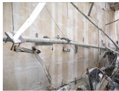
②プール壁異常なし
