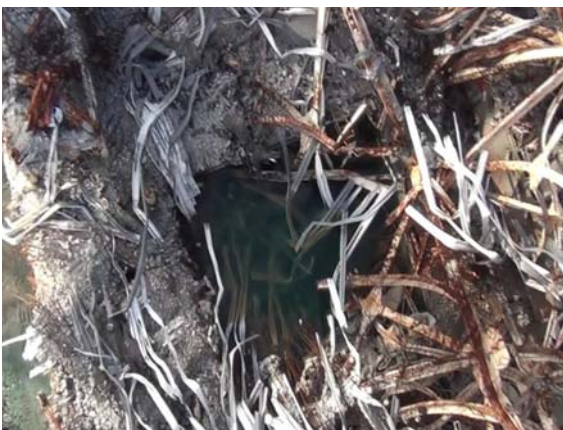
写真3 第3号機使用済燃料プール周辺の状況 (平成23年11月10日撮影)
