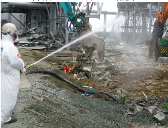
写真5 飛散防止剤の散布状況イメージ (平成23年8月9日撮影)
