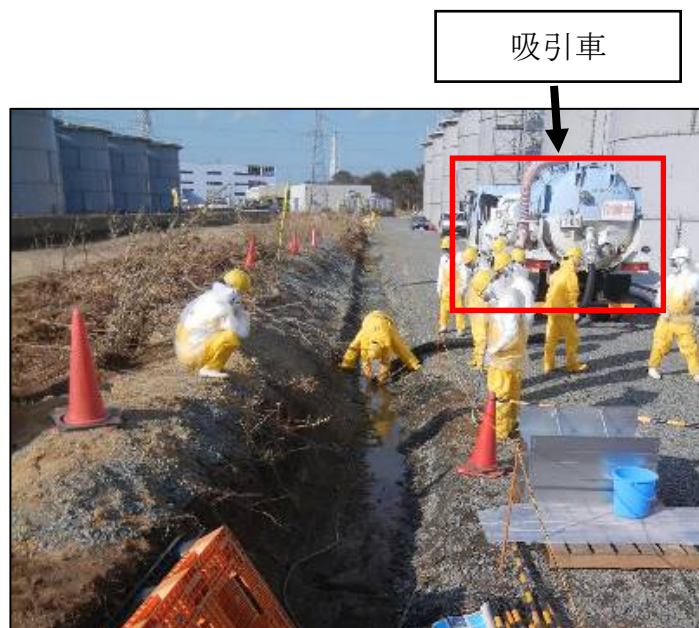
図9 漏えい物回収作業の様子
