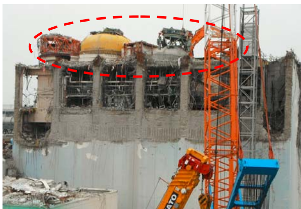
(a) オペフロ上部の機器 撮影日：平成 24 年 7 月 9 日
