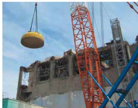
(b) 機器の撤去作業 撮影日：平成 24 年 8 月 10 日
