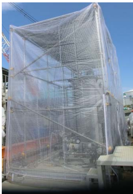
図1 機器スキッドのビニールシート養生の状況
