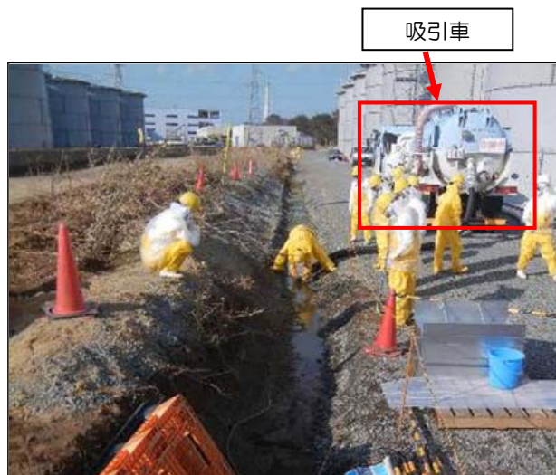
図 3 逆浸透膜装置移送ホースからの漏えい時の回収作業の様子
