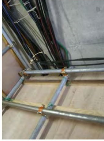
ケーブル引き込み口養生
