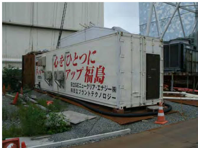
コンテナ外観
