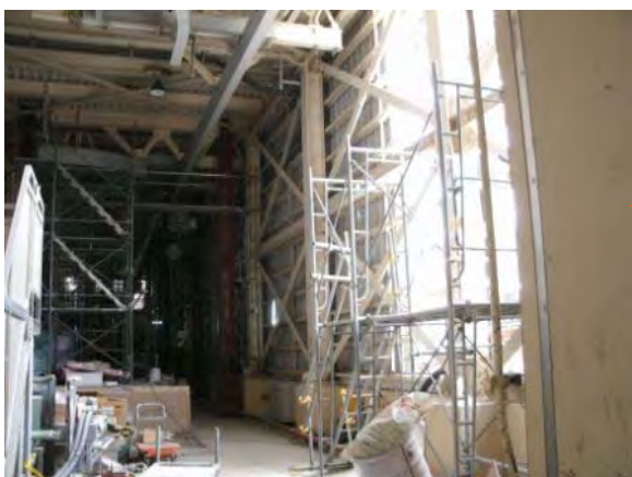
制御盤設置エリア南側 (一部壁無し)
