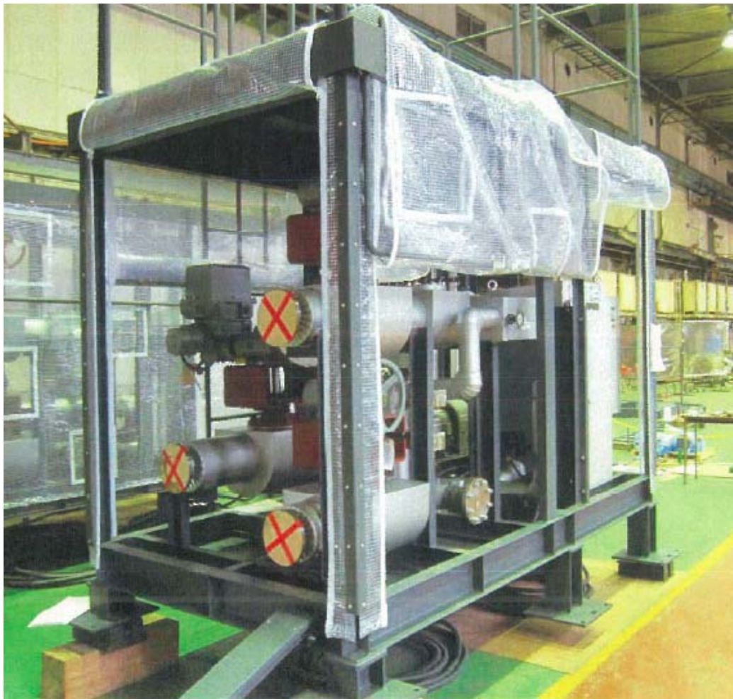
図1 機器スキッドのビニールシート養生の状況
