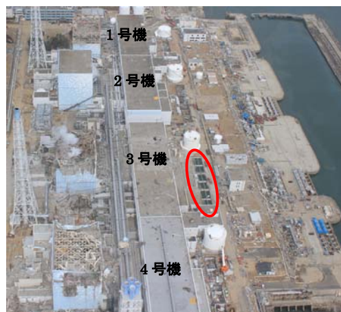
3 号機 復水器逆洗弁ピット
