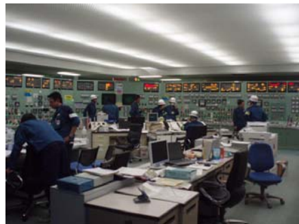
5,6号機中央制御室：6号機側
