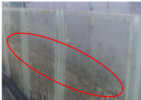
1号機タービン建屋1階 M/C の状況
