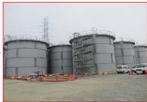
リプレイス後 (イメージ) 1,000 m^3 の地上大型鋼製円筒型タンク \times 42基 合計容量：42,000 m^3
