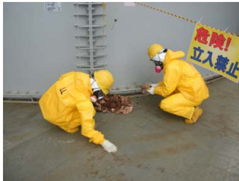
ウエスによる残水の拭き取り
