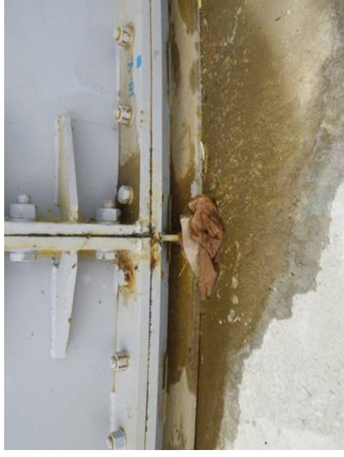
コンクリート基礎部
