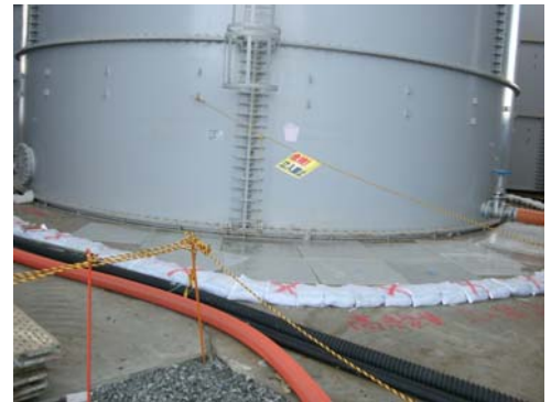
β線遮へい用アクリル板設置
