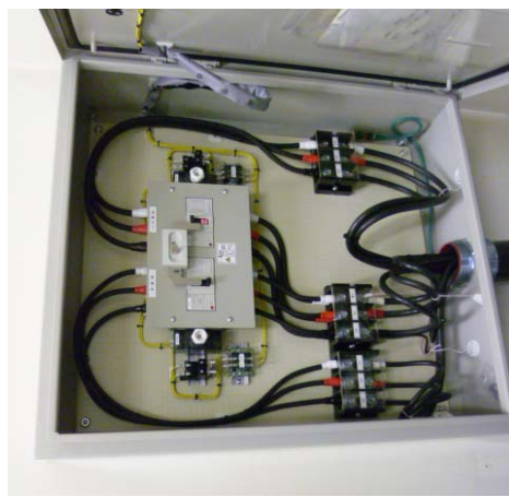
発電機回路盤(外観) 発電機回路盤(扉開時)
