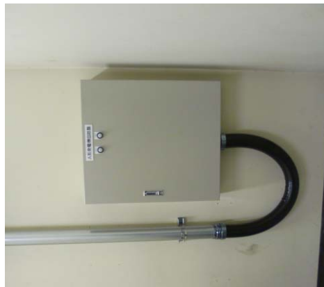
発電機回路盤(外観) 発電機回路盤(扉開時)
