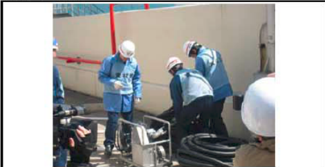
軽油タンクから抜き取り
