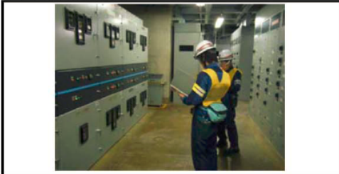
電源接続前準備
