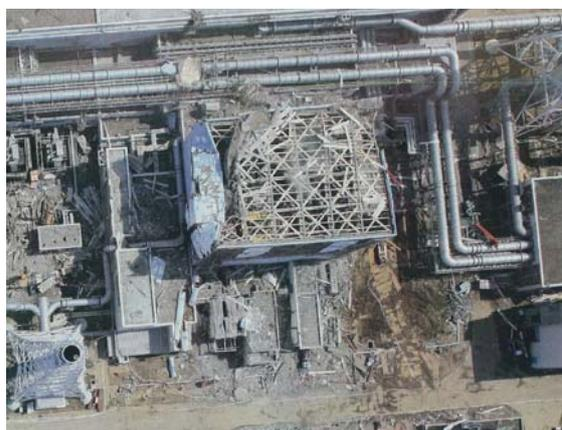
写真2 第4号機原子炉建屋の損傷状況
