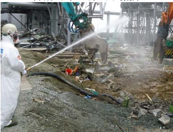
写真5 飛散防止剤の散布状況イメージ
