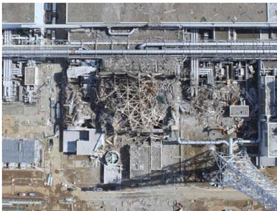
写真1 第3号機原子炉建屋の損傷状況
