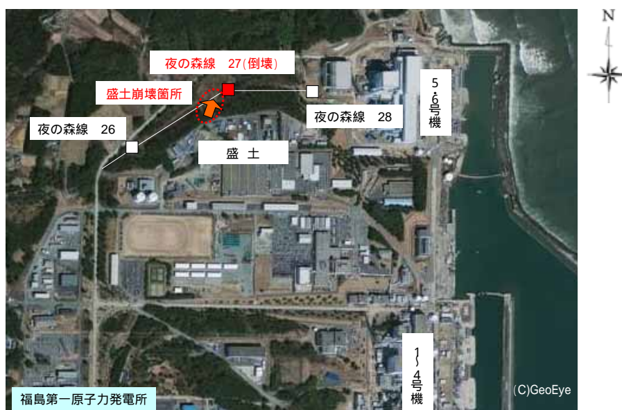
図 1：崩壊した盛土の位置
