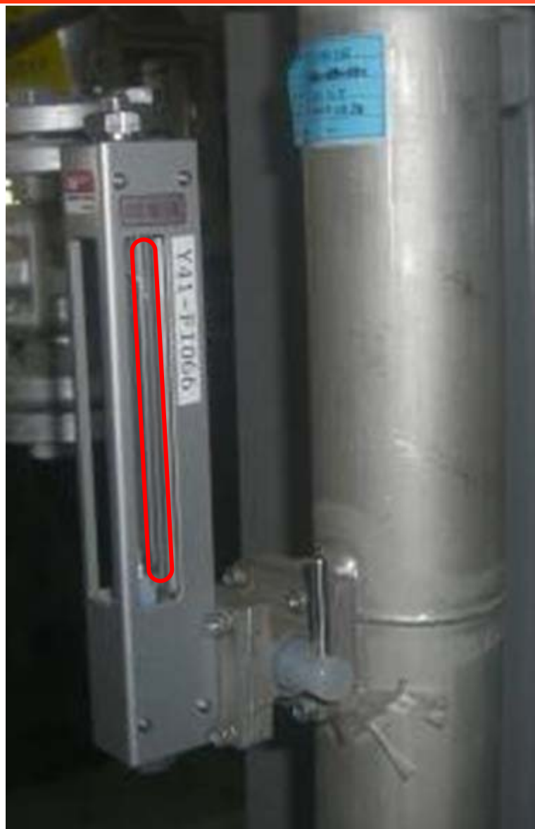
No.22: 純水装置 ろ過水ライン流量計
