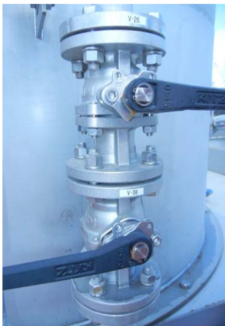
No.12 脱塩器入口ライン入口弁廻り
