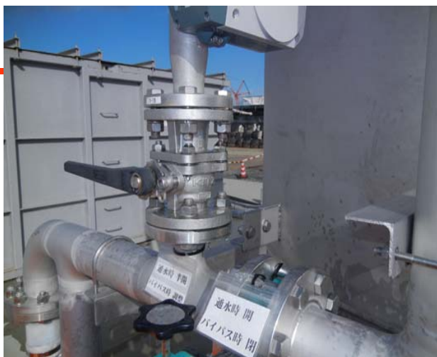
No.12 脱塩器入口ライン入口弁廻り
