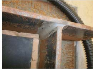
淡水化装置RO-2シール部修理後
