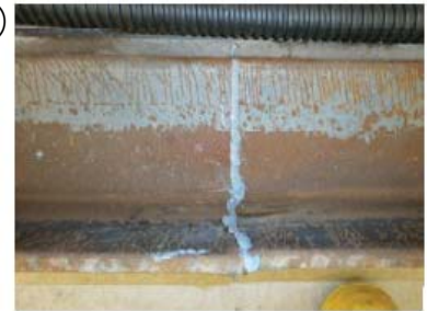
淡水化装置RO-2シール部修理後
