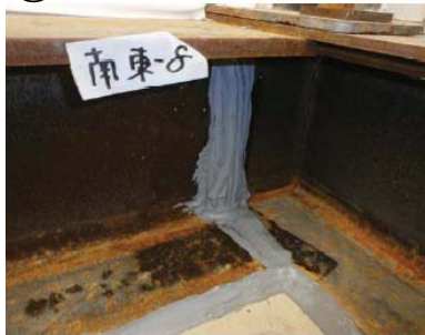
蒸発濃縮装置3Aシール部修理後
