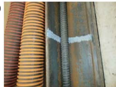
淡水化装置RO-2シール部修理後
