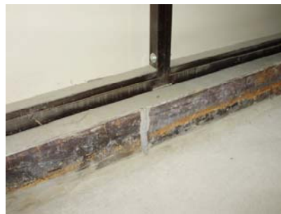
蒸発濃縮装置1A-1Cシール部修理後
