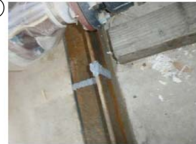
淡水化装置RO-3シール部修理後
