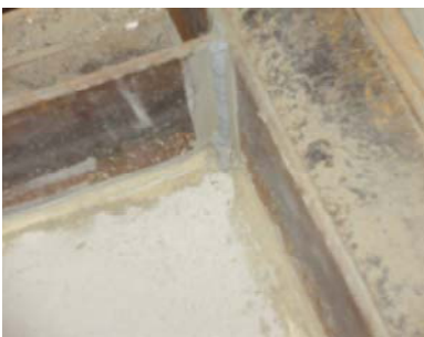
蒸発濃縮装置1A-1Cシール部修理後
