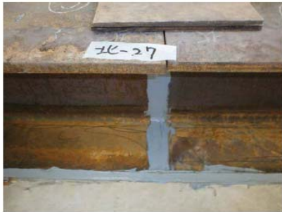
蒸発濃縮装置3Aシール部修理後
