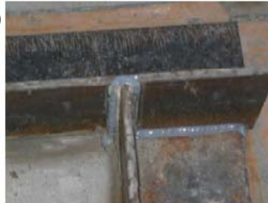
淡水化装置RO-1シール部修理後
