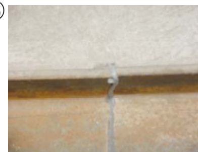
蒸発濃縮装置2A, Bシール部修理後
