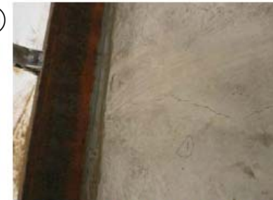
淡水化装置RO-3床ひび割れ修理後
