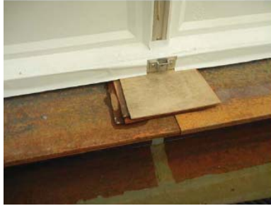
蒸発濃縮装置3Aシール部修理前
