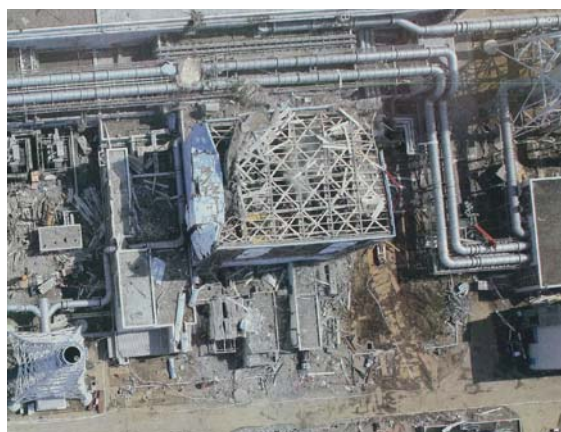
写真2 第4号機原子炉建屋の損傷状況 (平成23年3月24日撮影)
