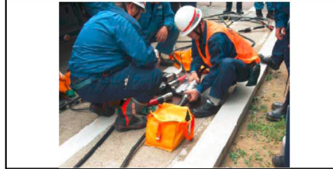
ケーブル接続
