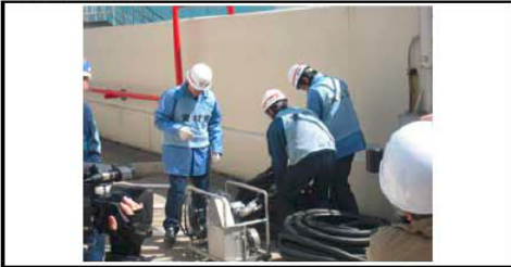
軽油タンクから抜き取り
