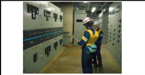
電源接続前準備
