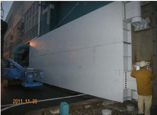
既設外部扉への水密パッキン取付および防潮板(開閉式)の設置を行い水密性能を向上させた。
