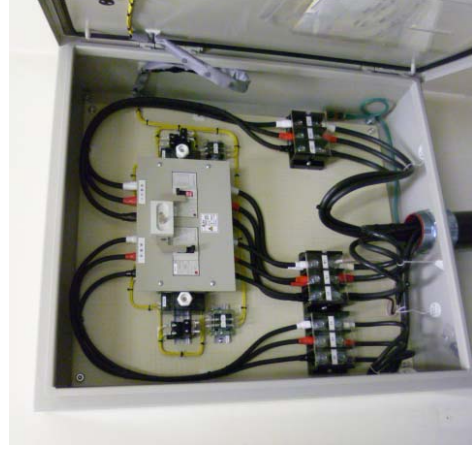
発電機回路盤(外観) 発電機回路盤(扉開時)
