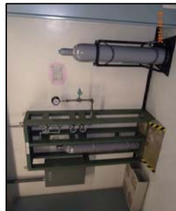
原子炉建屋地下1階 S/Cベント用空気ポンプ、予備ポンプ
