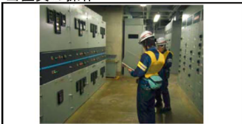
電源接続前準備
