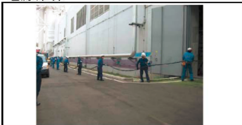
ケーブル布設・引き込み
