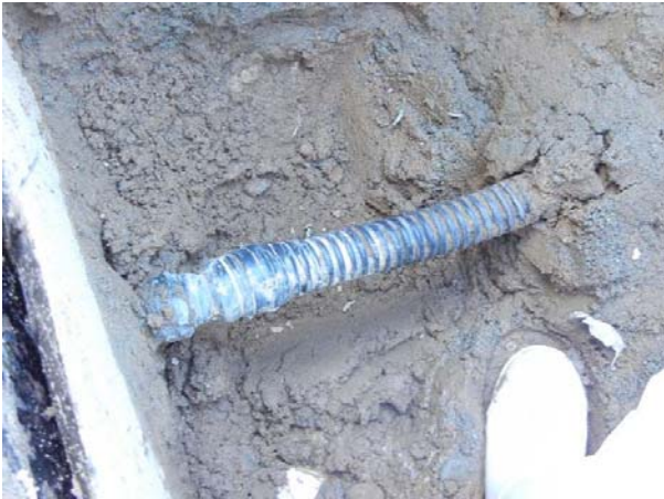
図4 ケーブル管路切断前後写真
