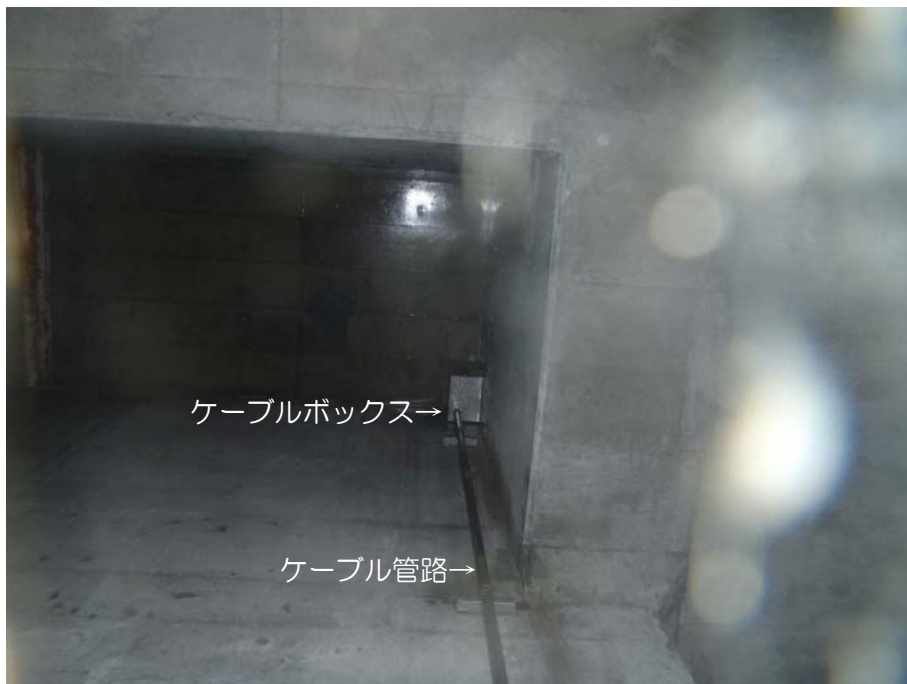
【写真①】 ケーブル管路を見上げた状況
