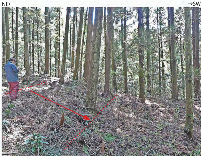
Loc.Y-6(いわき市遠野町入遠野上根本冷水) 2011.4.23 撮影 撓曲状地形の斜面部において、樹木が傾いている。
