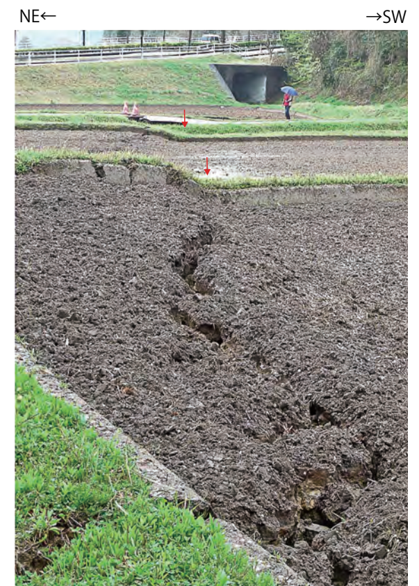
Loc.Y-25W 水田(沖積面)に出現した地震断層。 南西落ち約50cmの上下変位が認められる。
