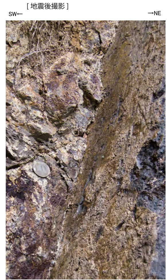
同左拡大。 断層面は平面的であり、断層面沿いに数 mm の軟質粘土が認められる。
