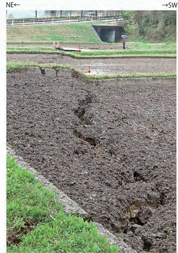
Loc.Y-25W(いわき市常磐藤原町松本) 水田(沖積面)に出現した地震断層。南落ち約 50cm の上下変位が認められる。
