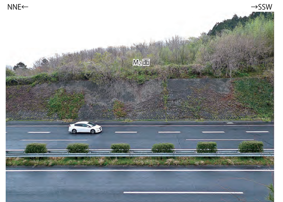
Loc.Y-19 湯ノ岳断層通過位置付近において、常磐自動車道の法面などに変状は認められない。
