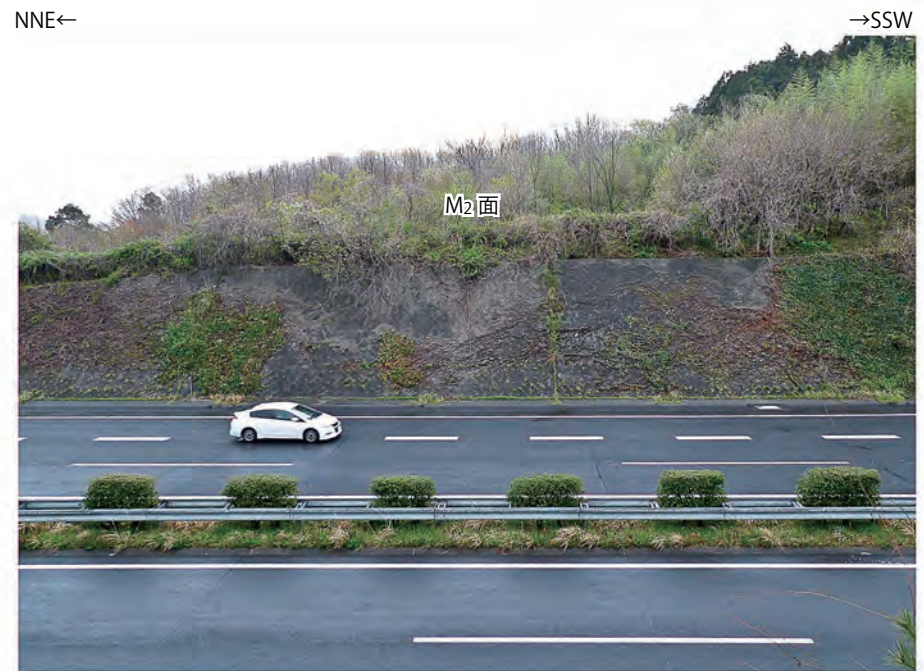
Loc.Y-19(いわき市常磐藤原町田場坂) 湯ノ岳断層通過位置付近において、常磐自動車道の法面などに変状は認められない。
