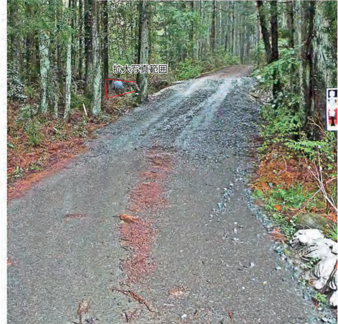
Loc.Y-7(いわき市遠野町上根本折松) 2011.4.23 撮影 路面に南西落ち約80cmの上下変位が認められる。
