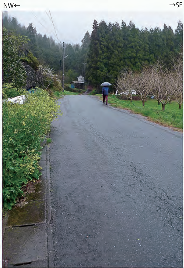
Loc.Y-10(いわき市遠野町深山田仲内) 湯ノ岳断層通過地点付近において変状は認められない。
