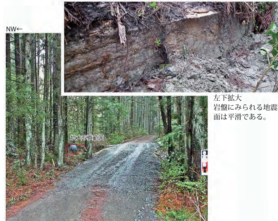
Loc.Y-7(いわき市遠野町上根本折松) 2011.4.23撮影 路面に南西落ち約80cmの上下変位が認められる。
