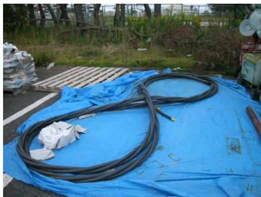
写真のケーブルは約 15m で重さは約 90kg。
