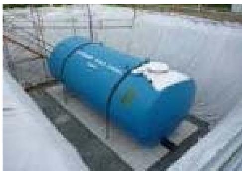
埋設の防火水槽（設置時のもの）
