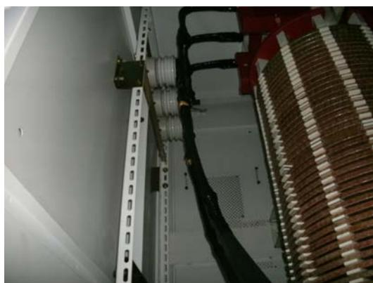
電源盤へのケーブル接続。3 線のケーブル端子が
