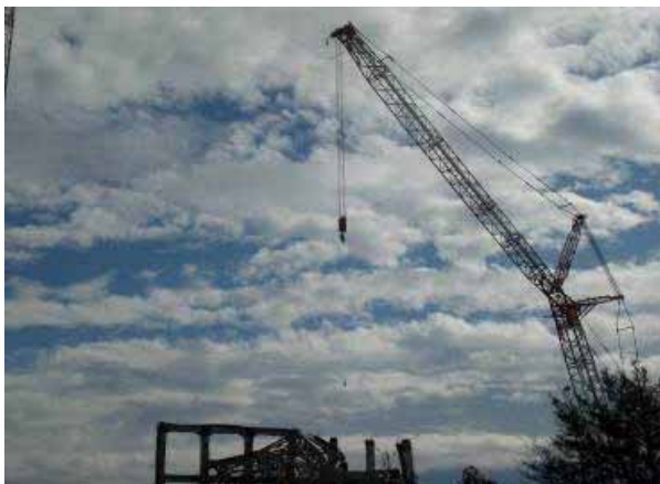
原子炉建屋上部の測定の様子
